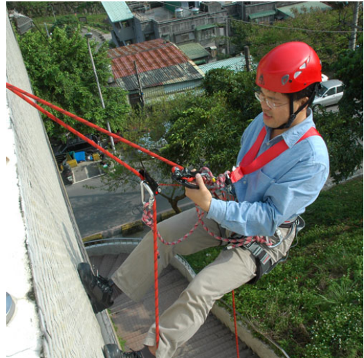
雙繩系統垂降：使用 I-BLOCK 垂降，使用 SHUNT 防墜
